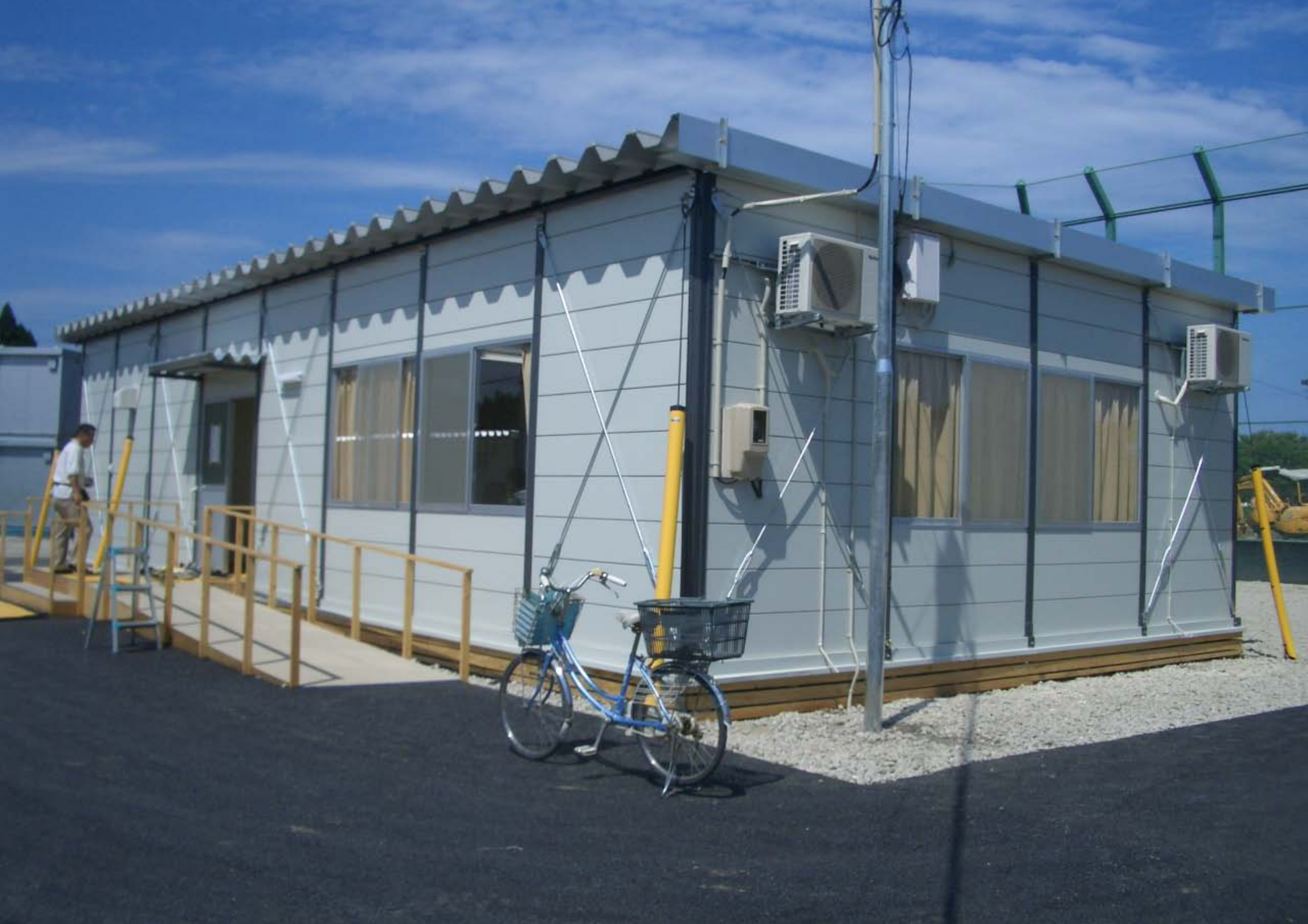
仮設住宅の集会室(市内に10カ所)
