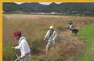
再生作業 (雑草、雑木等の除去)
