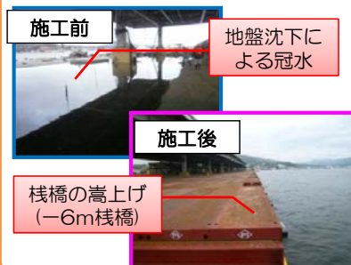
栈橋の嵩上げ(気仙沼漁港)
