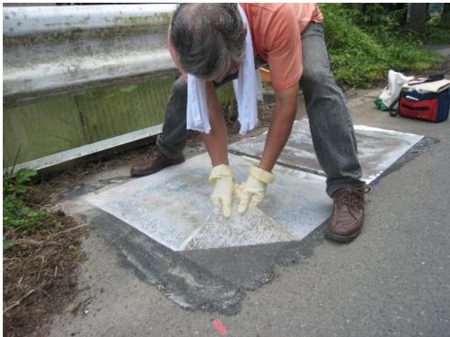
アスファルトのメジに入り込んだ放射性物質を、シュウ酸、クエン酸の泡を吹きかけ、洗濯糊で固め、剥離することによって放射性物質を除去する。
