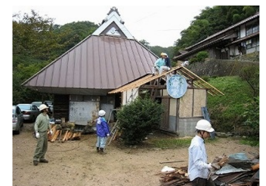
古民家改修作業
