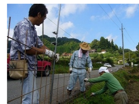
サル・イノシシ防護柵設置作業
