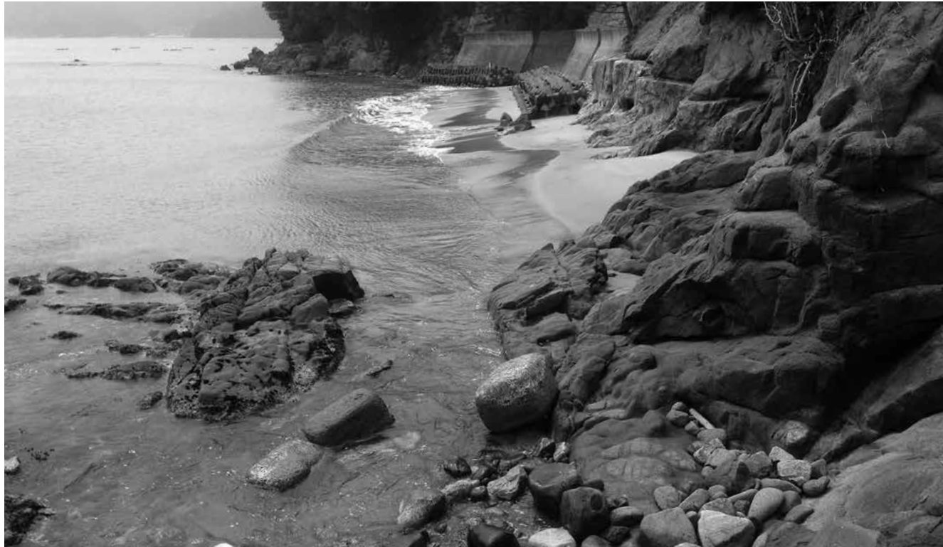
幼いころ、夏になれば毎日通っていた海。震災により手前の岩が崩れ危険な状態。地盤沈下で砂浜は海となってしまったが、干潮のときだけ現れる
