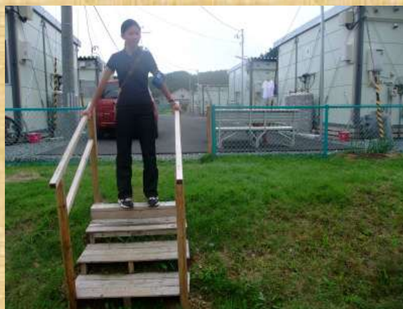
▲段差解消の手作り階段
