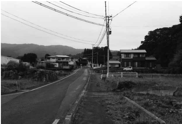
手前に並ぶ家は津波による浸水を受けたが自力再建へ。被災地では危険区域設定や、土地の造成等の影響で住居を建てられるところと、建てられないところがあり、その境目の写真
